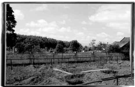
Fondations de la future école de musique de Mang La
